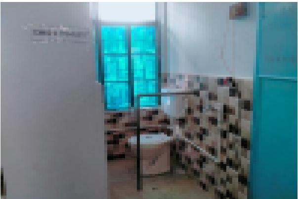
CWSN TOILET PHOTO
